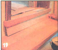
19 Устанавливают подступенок. Несколько паркетных дощечек склеивают в единую деталь и выкраивают из нее подступенок.
