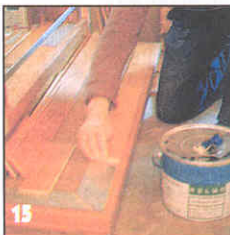
15 Клепки плотно прижимают друг к другу и к кромочной планкам. Выступивший из стыков клей сразу же вытирают.
