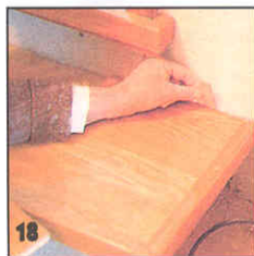
18 Укладывают склеенный последний ряд. Между паркетом и стеной вставляют деформационный шов.
