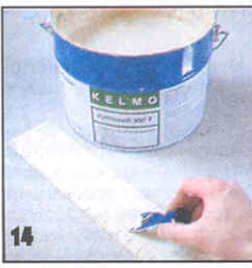
14 Теперь можно укладывать заранее подготовленные дощечки паркета.
