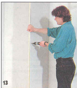
Несущую раму обшивают с обеих сторон гипсоволокнистыми плитами.
