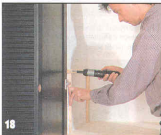
С помощью двух отрезков брусков одинаковой длины задают расстояние между опорами для полок.
