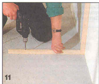
Бруски несущей рамы крепят непосредственно к стене и полу.
