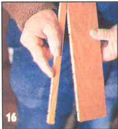
16 Если дощечки последнего ряда слишком узкие, их приклеивают к клепкам предшествующего ряда.
