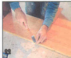
22 Порожек и прилегающие к нему клепки паркета прибивают гвоздями.
