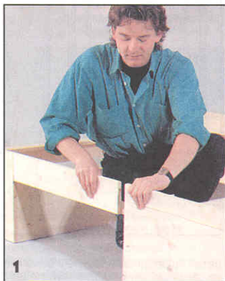
1 Склеивание на шпонках обеспечивает надежное соединение деталей.
