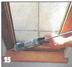
25 Швы заполняют герметиком.
