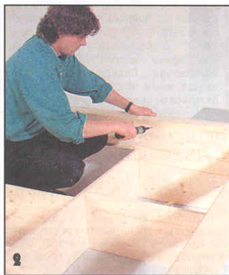
2 При соединении шурупами в деталях из столярной плиты предварительно сверлят отверстия.
