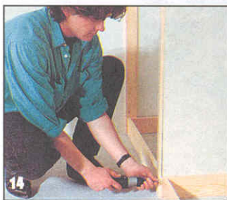
Снизу устанавливают цоколь из сосновых досок.
