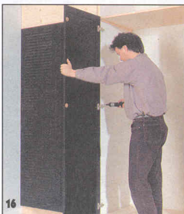
Мебельные петли-«лягушки» вставляют в заранее подготовленные гнезда, крепят к двери и корпусу шкафа. При навешивании двери для удобства под нее подкладывают бруски соответствующей толщины.
