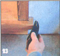
23 Паркетные доски продаются уже с покрытием, однако углы ступеней необходимо подшлифовать ...
